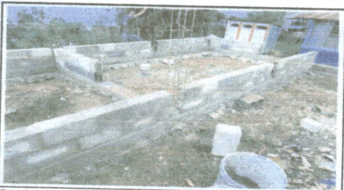
Foto 3: Implementacion de Paredes para un aula escolar del nuevo aula escolar.
