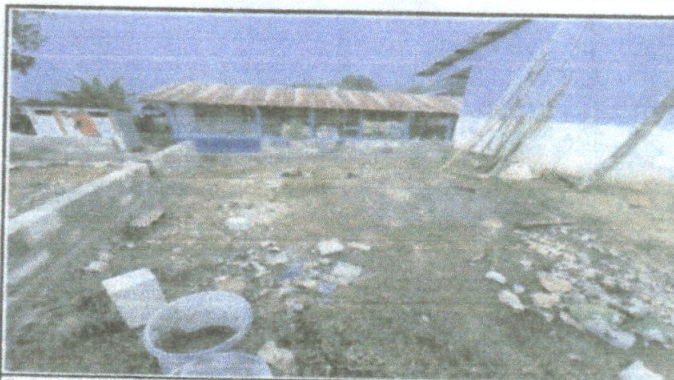
Foto 4: Colocacion de piso de torta de cemento del nuevo aula escolar
